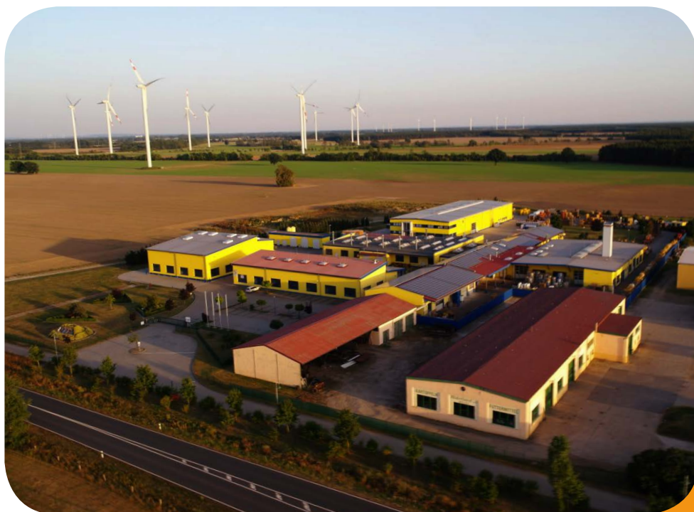
Energielandschaft in Uebigau-Wahrenbrück: PV-Anlage und Windpark im Ortsteil Bönitz Foto: Predl GmbH
