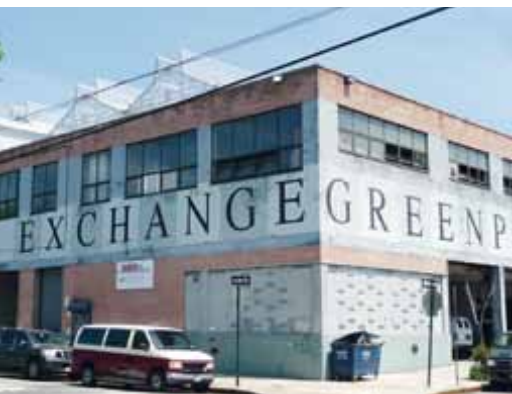
Dachgewächshaus Gotham Greens auf einem Industriegebäude in New York City
