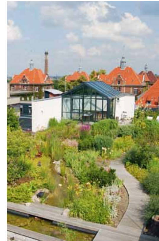
Auf dem Dach der Wiegmann-Klinik der DRK-Kliniken Berlin wurde ein Dachgarten als Rückzugs- und Erholungsbereich sowie als Ort der Begegnung für die Patientinnen/Patienten errichtet.
