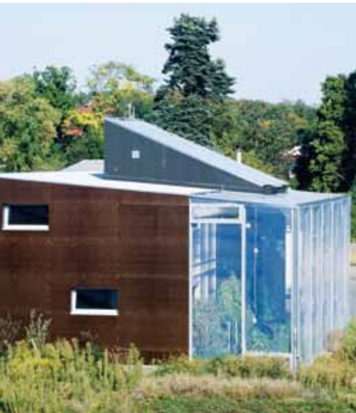
Watergy Gebäudeprototyp in Berlin mit Gewächshaus als Feuchtluft-Solarkollektor. Das Gewächshaus dient hier als Gebäudeheizung. Feucht-warme Luft aus dem Kollektor wird getrocknet und entweder direkt zur Beheizung in das Gebäude geführt oder für einen späteren Zeitpunkt bevorratet.
