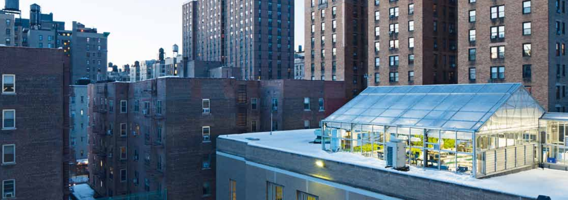
Dachgewächshaus der Manhattan School for Children in New York City, USA
