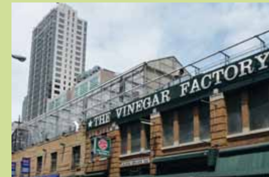
Der New Yorker Feinkosthändler Eli Zabar baut Tomaten, Salate und Paprika in Gewächshäusern auf einem Supermarktdach an. Verkauft und verarbeitet werden die Produkte im angrenzenden Supermarkt und Restaurant. Die Abwärme ☺ der Bäckerei wird zur Beheizung des Gewächshauses genutzt.
