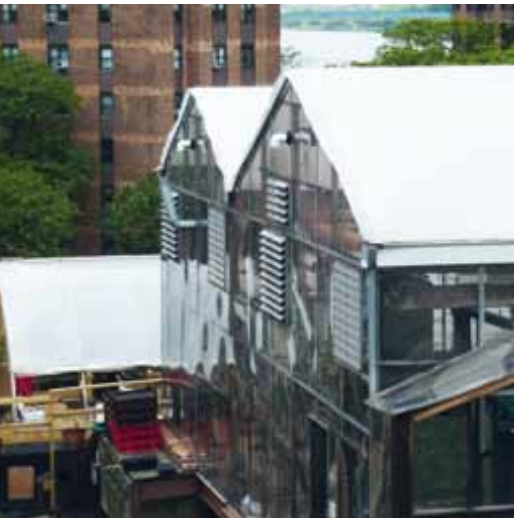
Dachgewächshäuser des Feinkosthändlers Eli Zabar auf einem Supermarktdach in New York City
