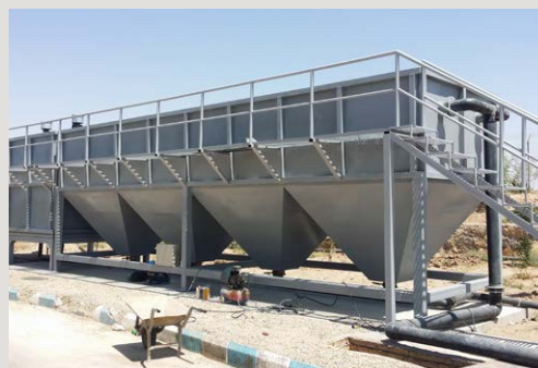
ته نشینی شیمیایی؛ تأسیسات استفاده مجدد از پساب مورچه خورت
