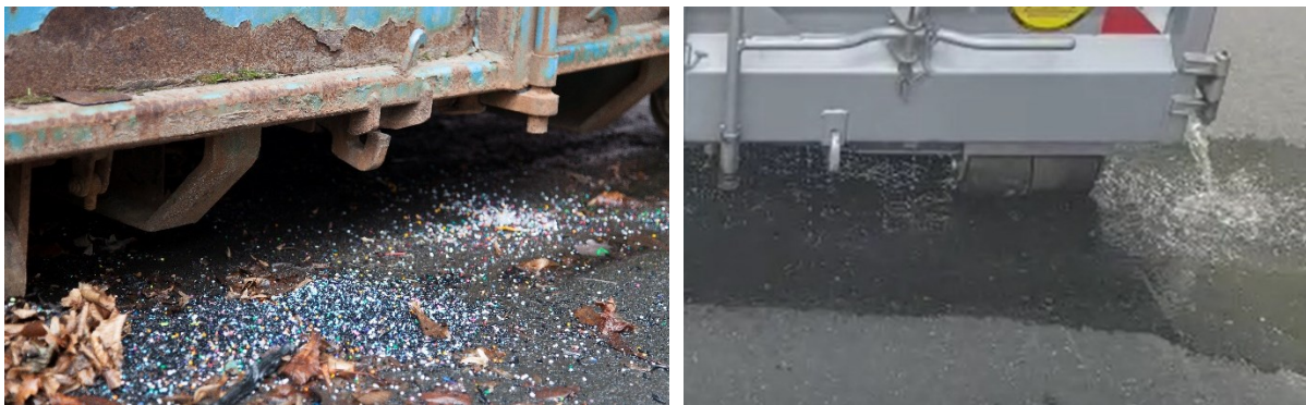
Abbildung 15: Hofffläche an Abrollcontainer bei der Leerung vor und nach Erneuerung der Mulde
